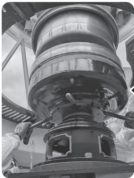
水銀槽を降下させ水銀を完全回収
