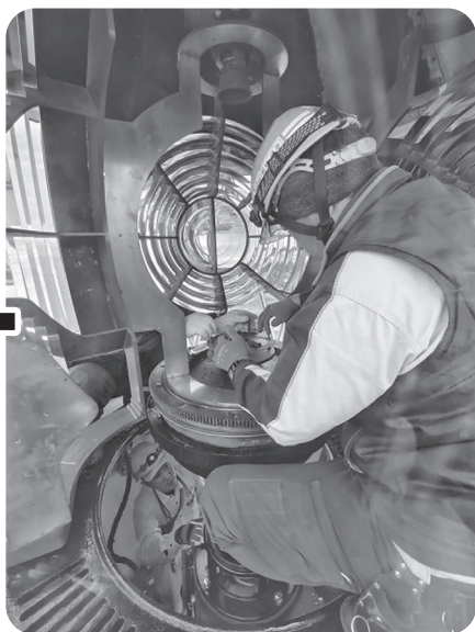
水銀回収後、レンズ内部の灯器を撤去
