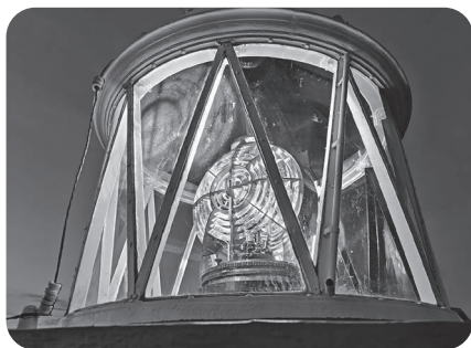
点灯回転する生地鼻灯台のフレネルレンズ（昨年8月撮影）
