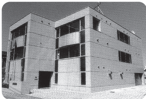
東京航路標識事務所
