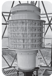
写真4： LED灯器設置後※
