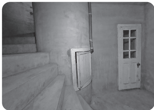
写真8 地下室への扉
