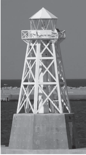
伏木外港東防波堤灯台 (平成29 (2017) 年撮影)
