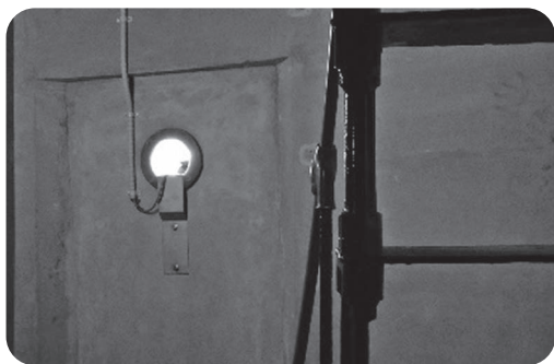
写真9 劔埼灯台の日光弁
