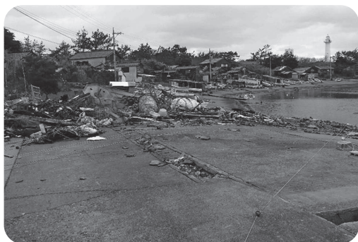
写真2 舢倉島津波被害状況2
