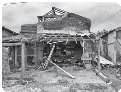
写真10 今もお津波の傷跡が残る住宅
