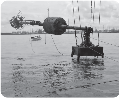
浮体式灯標の上部構造物交換工事
