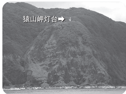
写真7-1 震災後～猿山岬崖崩落
