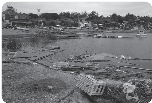
写真1 舢倉島津波被害状況
