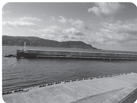
写真2 震災前の皆月漁港（R5.11.1撮影）
