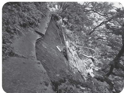
写真10 豪雨により巡回路崩壊
