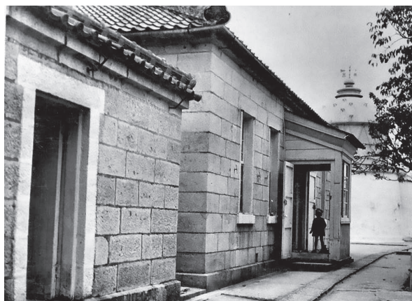
図8 江崎灯台の石造官舎と倉庫 （清水節代様提供写真）
