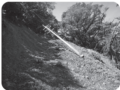
写真11 豪雨により電柱倒壊
