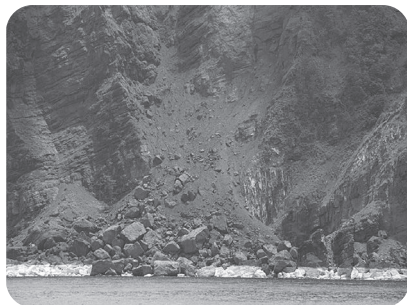
写真7-2 震災後～猿山岬崖崩落
