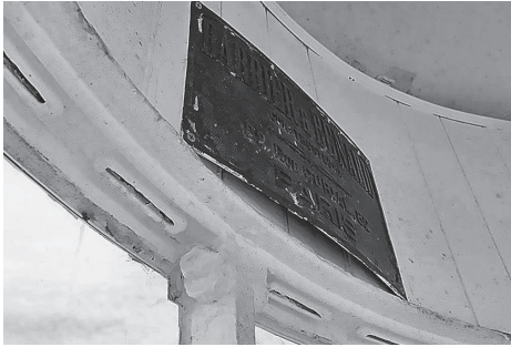
図-11 白洲灯台の灯籠屋根の銘板
