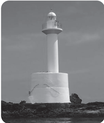
③ 復旧状況
