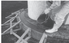
亀裂部の補修を行い、海水や雨水の浸入を遮断する。
