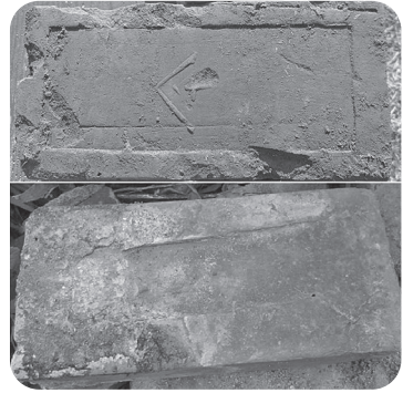
形状の違う灯台煉瓦 (安乗埼灯台調査)
