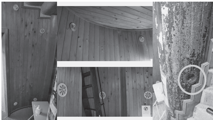
図10 潮岬灯台内部の通気孔 最右；支柱の通気孔
