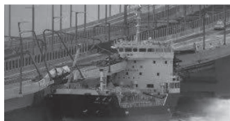
関西国際空港連絡橋被害状況
