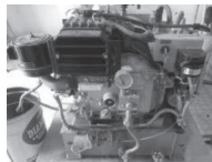
老朽化発電機の換装
