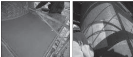
小規模修繕（部分修繕/防水、タイル修繕等）
