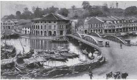
図13 記念プレートのリード橋 (上) と 1908年頃のリード橋 (下)
