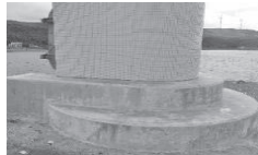
亀裂部の補修を行い、海水や雨水の浸入を遮断する。
