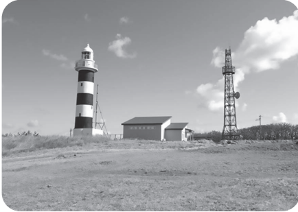
入道埼灯台の外観
