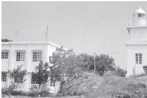
能登観音埼灯台と旧鵜浦航路標識事務所 1975年（昭和50年）
