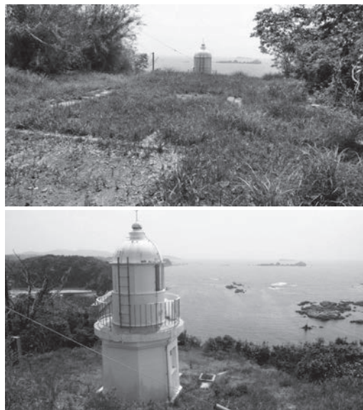
写真－1 特牛灯台の構内の全容 (令和元年5月撮影)
