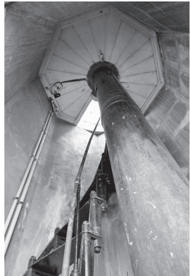
写真-7 蓋井島灯台の灯塔 内部（令和3年10月撮影）
