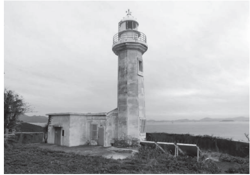
写真-6 蓋井島灯台とソーラーパネル（右下） （令和3年10月撮影）
