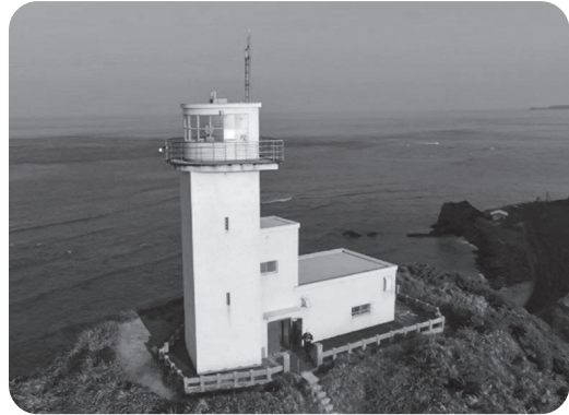
笠利埼灯台の全景（ドローン撮影）
