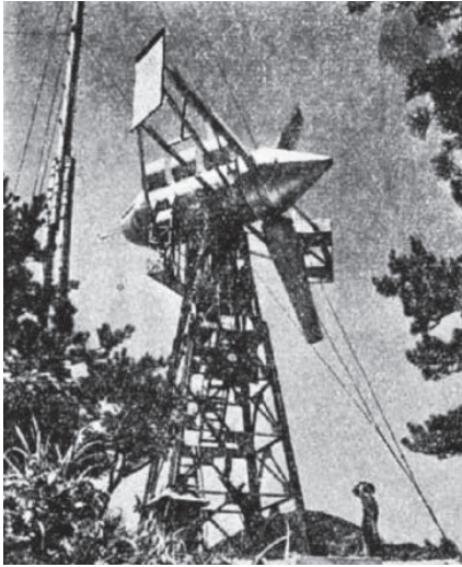
写真-4 蓋井島灯台の風力発電装置 (燈光昭和28年5月号記事掲載)
