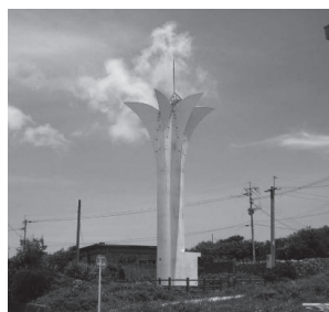
伊延港導灯 H 6.3 設置 (ユリの花をデザイン)
