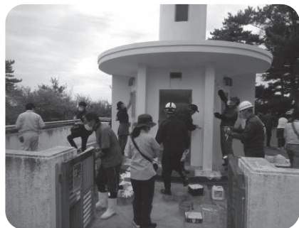
< 灯台塗装作業風景 >
