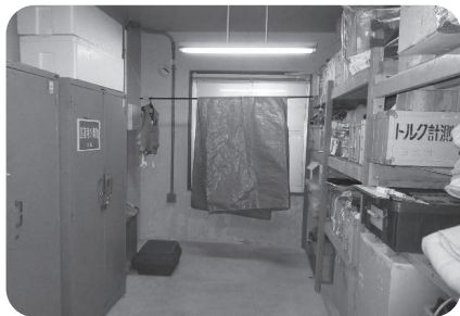
写真① (旧倉庫施工前)
