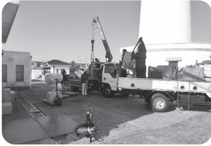
写真⑩（搬入状況）
