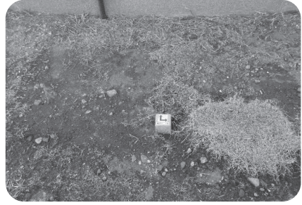
写真⑰（電源埋設標）
