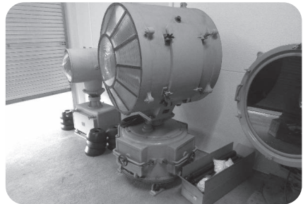
写真㉑（大型灯器固定）
