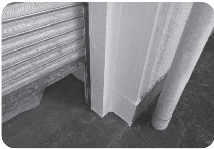
写真⑳（シャッター廻り）
