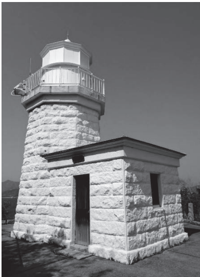
写真-8 大下島灯台 (平成31年4月撮影)
