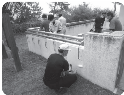
< 外壁塗装作業風景 >
