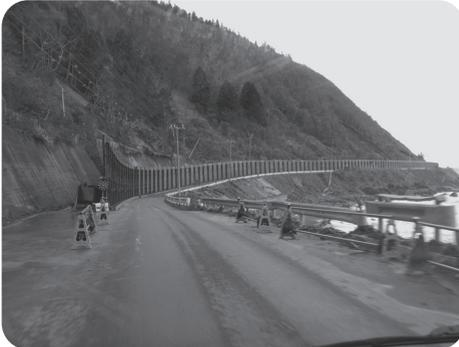
〔令和3年8月の大雨により一部崩落した小赤川橋（むつ市大畑町）。現在も仮橋が設置。復旧工事のため未だ片側通行が続く国道279号線〕
