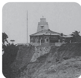
写真―2（建設当時）
