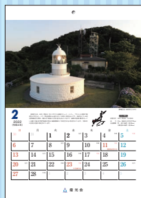
部灯灯台 (福岡県北九州市)
