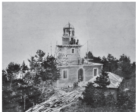
建設工事中の初代観音埼灯台 (フランス国立公文書館所蔵)
