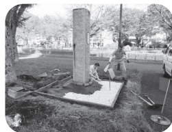
作業中の様子
