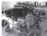
老朽化発電機の換装
