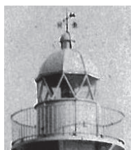
横浜突堤_29.05 無等級 不動灯
