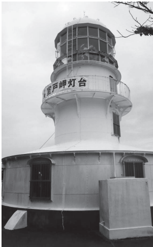
写真－1 室戸岬灯台 （令和元年11月撮影）
