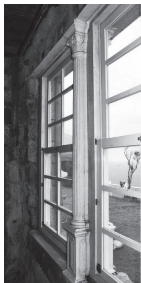
写真-9 退息所窓のコリント式円柱 (令和元年11月)
