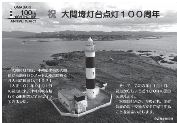
パネル「大間埼灯台点灯100周年」
