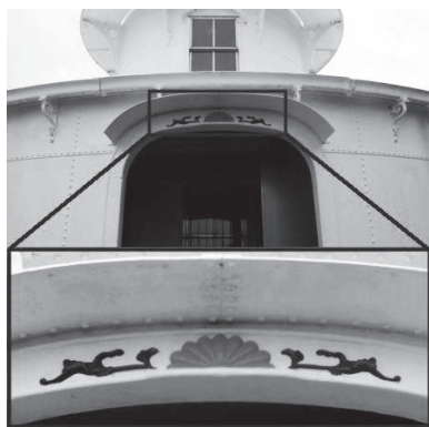
写真11 灯台入口上部の半菊 （令和元年11月撮影）
