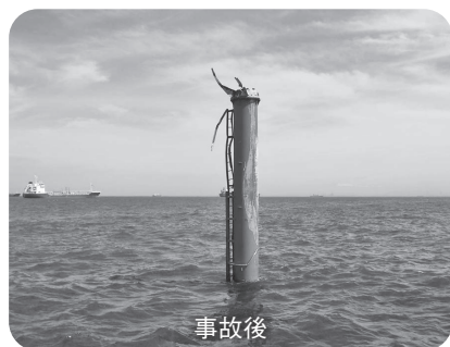
船舶の接触による損傷
