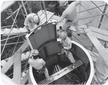
FRP製パネルの組立
