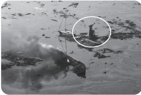
海上火災により焼け焦げた灯標
