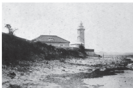
写真－7 明治36年頃の男木島灯台 （燈光会所蔵「燈臺要覧」より）
