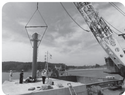
灯塔吊込み状況
