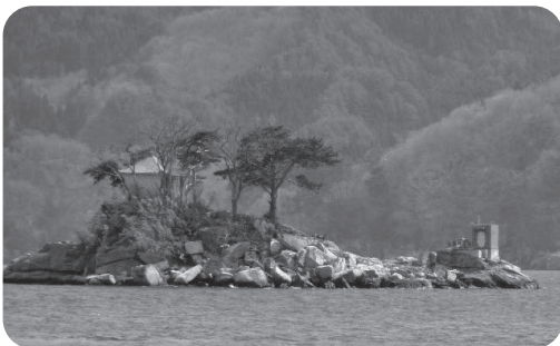
津波により灯台上部が倒壊
