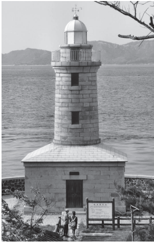
写真—1 男木島灯台 (平成25年5月撮影)
