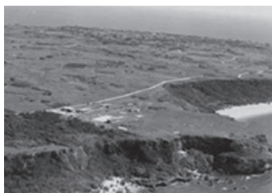
写真－5 広大なロラン局敷地
