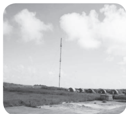
写真－8 灯浮標保管状況、コン クリート基礎は元ロラン無線舎跡 後方：元ロランアンテナ、ディフ アレンシャル用中波アンテナ
