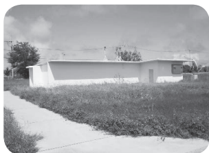
写真－9 ディファレンシャル GPS局舎（平成18年当時）
