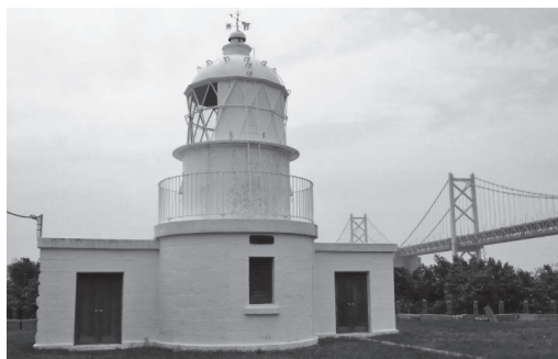
写真－1 鍋島灯台と備讃瀬戸大橋 （本年8月撮影）
