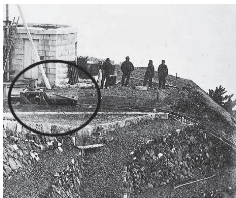
写真－3 部埼灯台建設時のリフトとレール （燈光会保管写真より）
