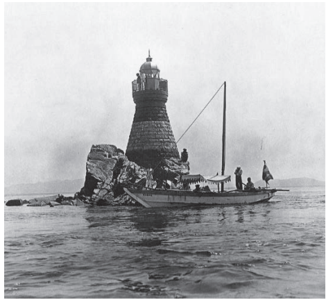
写真-11 当時の波節岩灯標 (大正15年再版「燈台」掲載写真)
