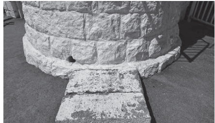
写真4～7 灯台の貫通孔
