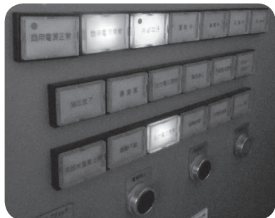
非常用発電機制御盤とエラー表示
