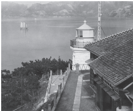
在りし日の大下島灯台と退息所 (燈光会保管写真より)
