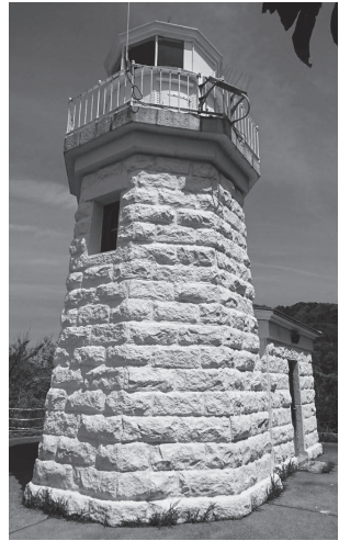
八角形の大下島灯台 (平成31年4月撮影)
