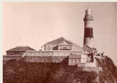
建設当時の塩屋埼灯台
