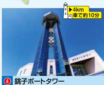
④ 鉾子ポートタワー
