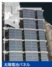
太陽電池パネル
