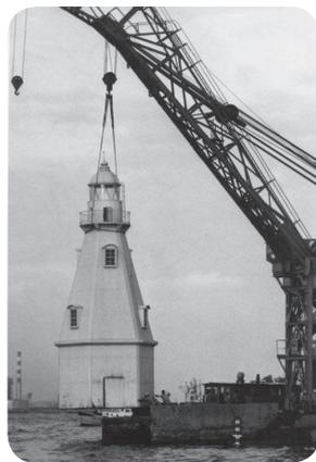
写真—2 撤去移設される旧横浜東水堤灯台（昭和38年3月撮影）
