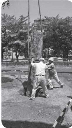
水島さんが私費で購入してきた砂利を最初に投入、自重を利用して軽くトントンと締め固めをして深さ計測。当初目論見どおりの1.2メートルちょいの埋め込み長が確保。トランシットを利用して傾斜測定をしてみるが、90度違う位置から確認して、どちらも1ミリの誤差もないくらいに真っ直ぐ立っている。ほとんど奇跡。しばし、クレーンに支えてもらい順次の埋め戻し、転圧を繰り返す。支えのロープを外した時点で再
