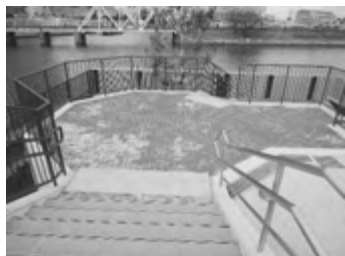
写真-13 洋式試験灯台の8角形の基礎部を再現
