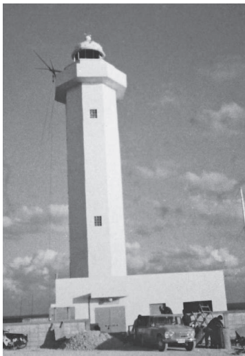
写真-2 平安名埼灯台建設中2
