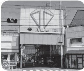
写真③ 宿舍側入口
