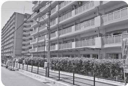
写真④ 市営住宅
