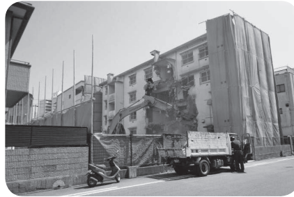
写真⑤ 重機による解体
