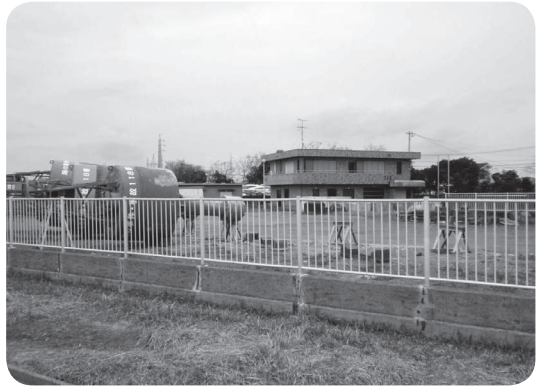
写真-1 八代浮標置き場 (奥の建物は元八代航路標識事務所)
