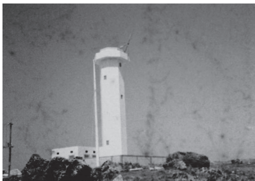
写真-1 平安名埼灯台建設中1
