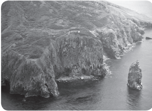
写真-5 臥蛇島灯台遠景
