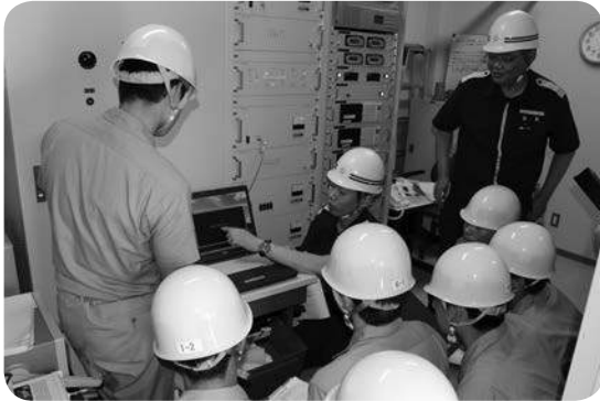
写真-3 丹後ディファレンシャルGPS局舎での送信設備の説明
