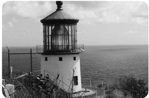
写真―4 1等レンズがおさめられているマカプウ灯台
